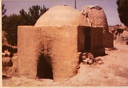
RESİM 2: Üretilenlerin pişirildiği kerpiç fırın ve kullanılmayan tuğla fırın
