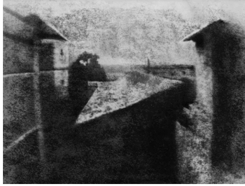
Resim 1. Saint-Loup-de-Varennes'de pencereden görünüm (Pencereden Manzara, 2020).
